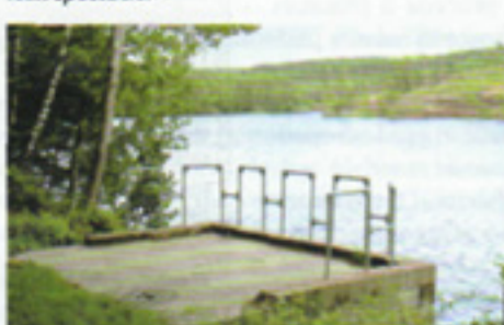
Poste de pêche aménagé au bord du lac de la Vierre pour les personnes à mobilité réduite.
